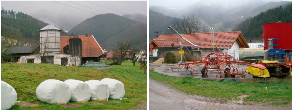
Oberried 6.12.2008: hinten der Gasbehälter-Turm; rechts vorn: unterirdischer Gärbehälter, dahinter das BHKW-Gebäude. Quellen zu Oberried: www.ecotrinoa.de Samstags-Forum Regio Freiburg, 6.12.2009. Fotos G. Löser
