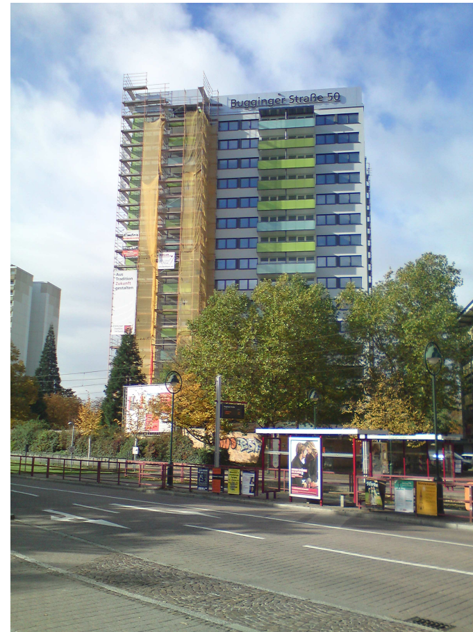
Nach Sanierung / After renovation
