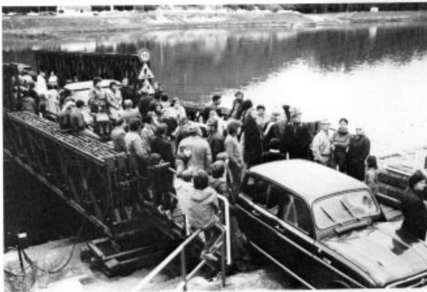
Sperrung des Grenzüberganges auf der Sasbacher Rheinbrücke
