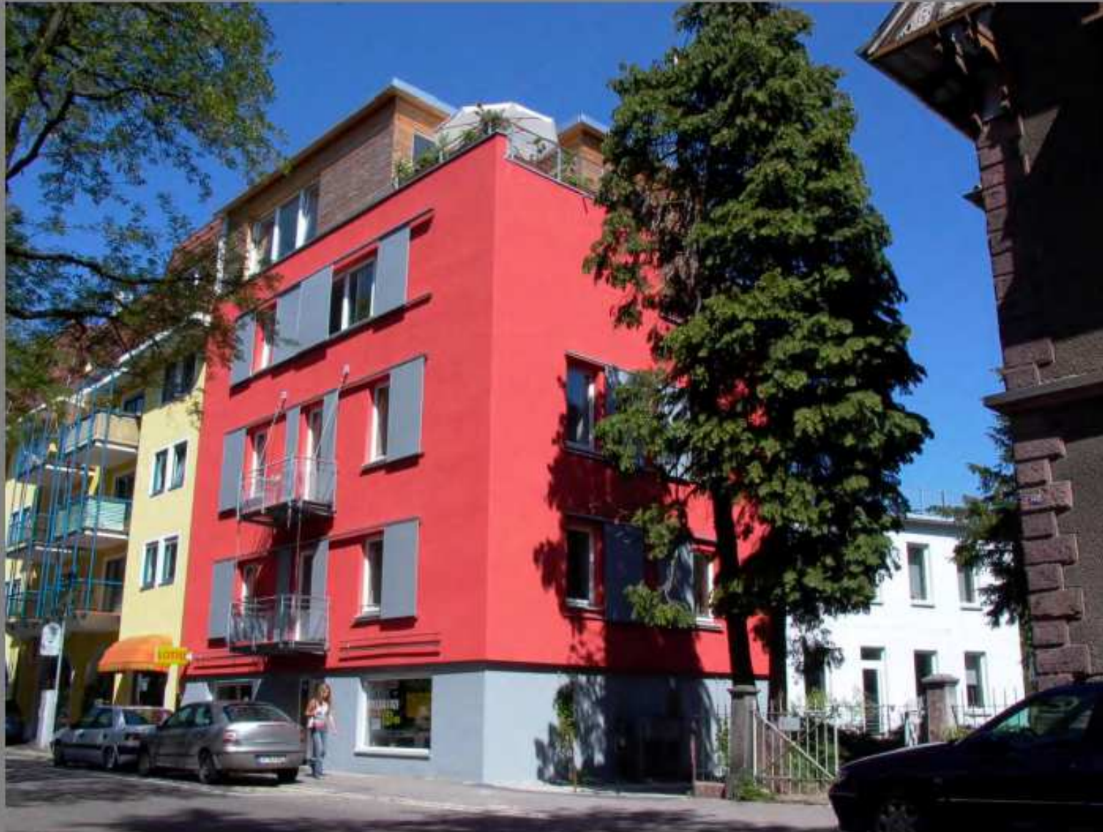
Aufstocken und Dachausbau für mehr Wohnraum
