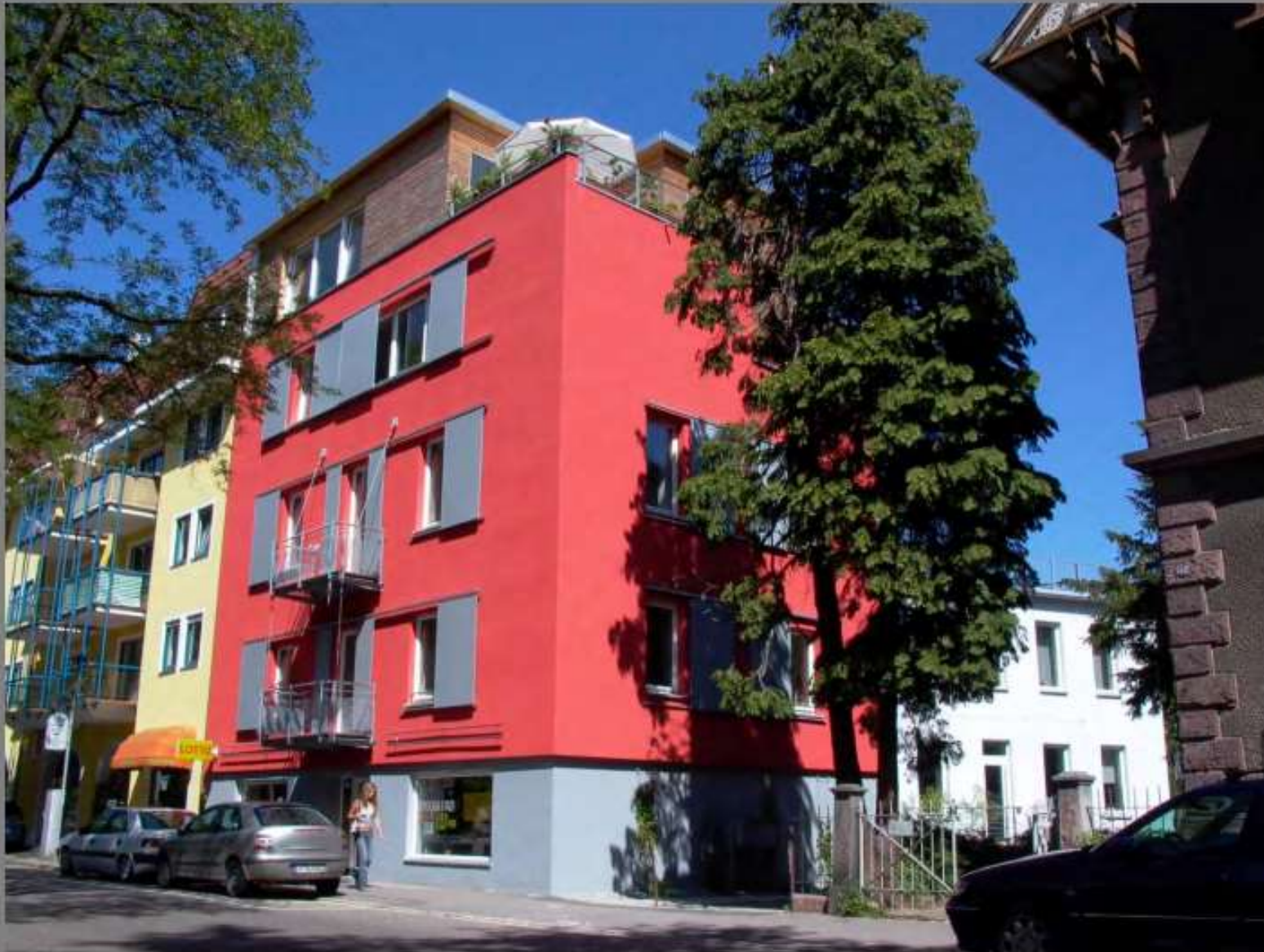
Aufstocken und Dachausbau für mehr Wohnraum
