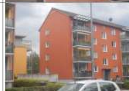
170721-492kl. Ecke Fehrenbachallee 39a- 41..Bauverein Foto G.Löser JPG.jpg
