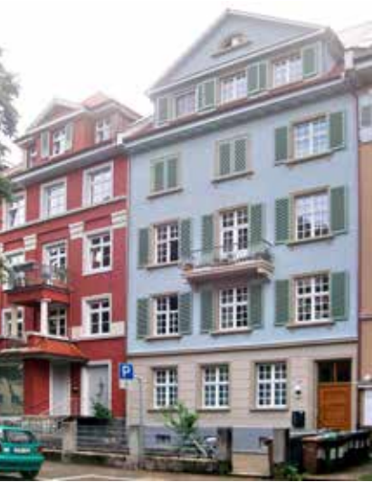
Denkmalgeschütztes Doppelhaus in Freiburg-Herdern senkte den Energieverbrauch stark dank Mini-BHKW und Wärmedämmung. Foto (c) G. Löser
