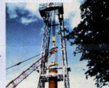
Bau Schacht Asse 4
