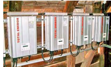
die Wechselrichter
