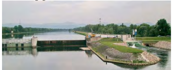
Das Kulturwehr des Altrheins bei Breisach, Kleinkraftwerk bei Breisach
