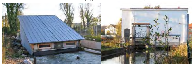
EM: Schneckenkraftwerk Kreuz (li.) & Wasserkraftwerk, Ramie-Gelände
