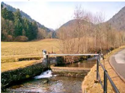
eines der beiden Wehre mit Fischpass
