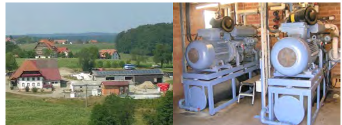
Biogasanlage Reinbold : Die Gärbehälter sind in den Boden eingelassen. BHKW-Motoren der Biogasanlage in rotem Gebäude in Bildmitte.
