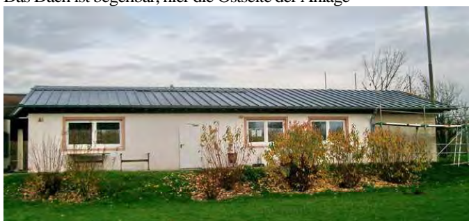
die Westseite der Anlage
