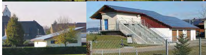
Abschiedshalle: 22 kW p , Erweiterung Kläranlage: 36 kW p
