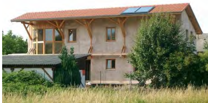
Das <Haus in Stroh>, noch vor dem Außenanstrich
