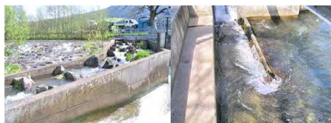
li.: Die rauhe Rampe des Wehrs und ein Teil des Fischeufstiegs re.: Mit einer besonderen Lockströmung werden Fische vom Rechen (Bildmitte) weg nach links in den Fischabstieg gelockt.
