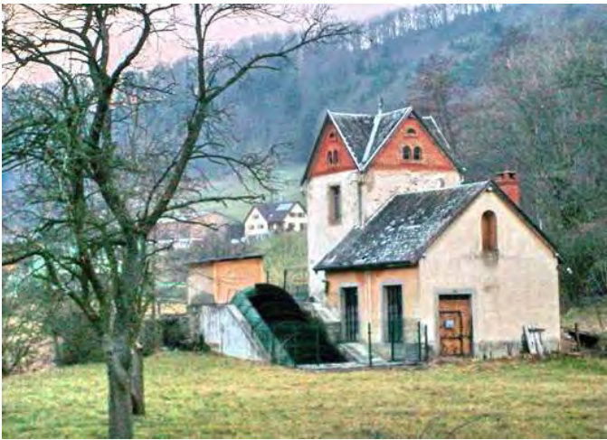
Blick von der Brücke über die Weiss zur Wasserkraftschnecke und zum alten Kraftwerksgebäude
