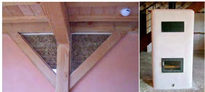
Vitrine in tragender Außenwand mit Strohballen; Ofen
