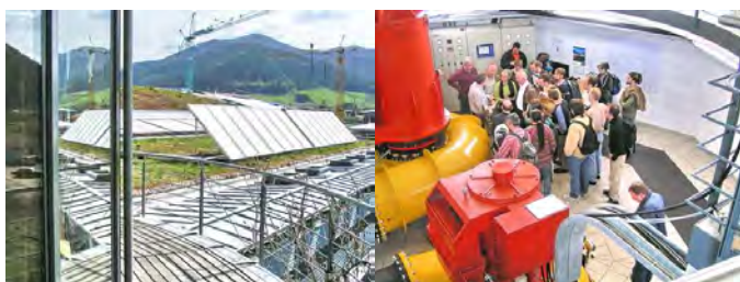
Oben: Werksansicht. Unten im Rundbau befindet sich das von außen einsehbare Wasserkraftwerk. Unten links die Solaranlage, rechts Führung bei der werkseigenen Wasserkraftanlage
