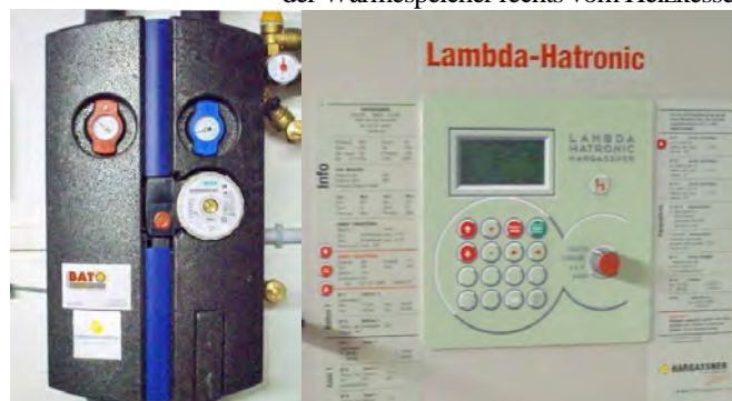
Pumpe und <Solarstation> Regelung des Heizkessels
