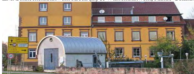
EM: Wasserkraftwerk EEE bei der Mundinger Mühle
