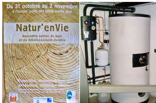
der Wärmespeicher rechts vom Heizkessel
