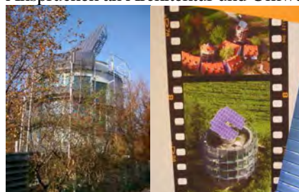
Heliotrop, Bj. 1994, Architekt Rolf Disch, Freiburg i.Br., li. Foto 2008 re. Foto von Poster Rolf Disch, 2006. Mehr: www.rolf-disch.de www.solarsiedlung.de
