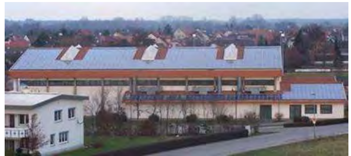
Wyhl: Sporthalle, Tullastraße, Solarstrom seit Oktober 2004
