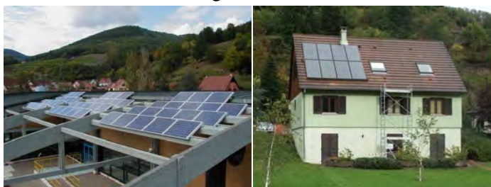
links : Solargeneratoren ; rechts Sonnenkollektoren des Espace nautique von Kaisersberg, rue du Geisbourg; Fotos CCVK
