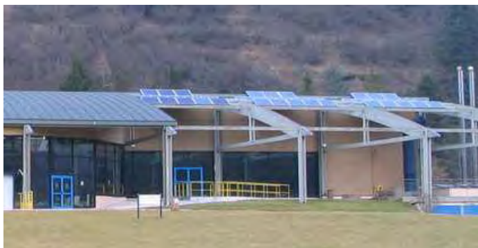
Schwimmzentrum Kaisersberg : mit Solargeneratoren auf dem Dach, rechts die Kamine der Heizungsanlage, Foto E. Schulz
