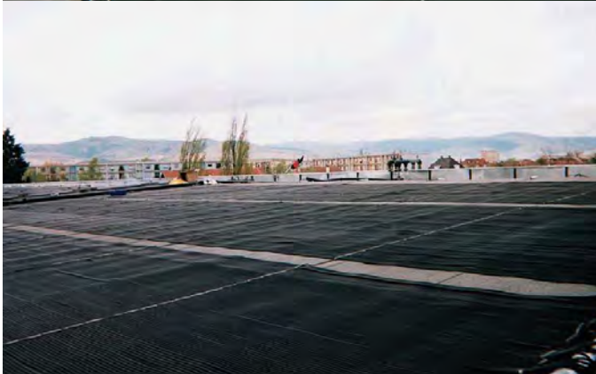
Solar-Absorbermatten auf den Dächern des Schwimmstadions Colmar
