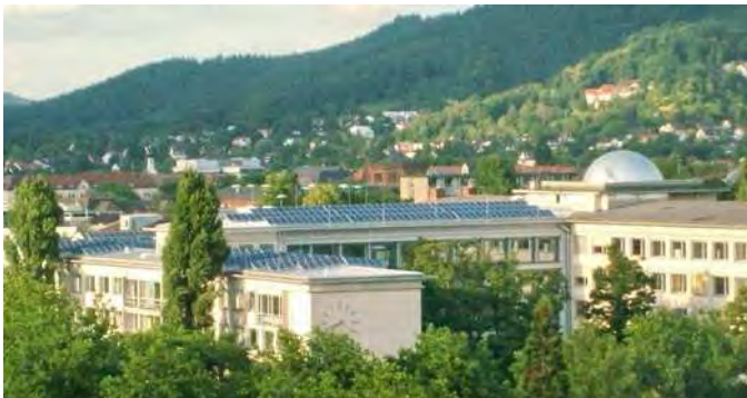
Richard-Fehrenbach-Schule (weitere PV-Anlage auf der Gerhard-Graf-Sporthalle)
