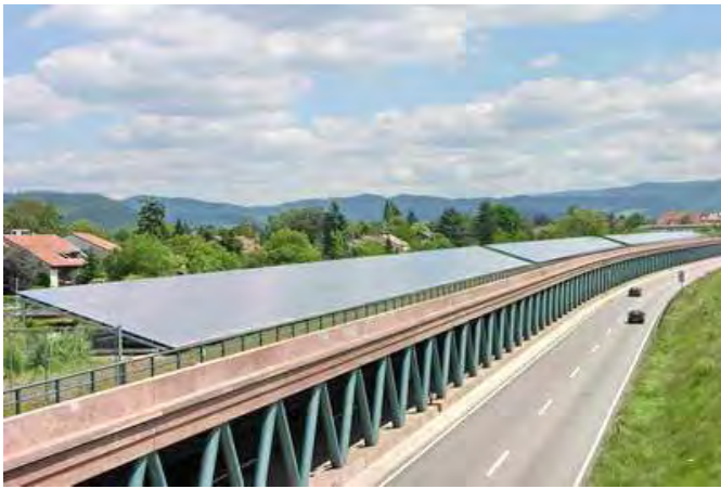
B31-Ost in Freiburg mit 366-kW-PV-Anlage, Foto fesa-GmbH
