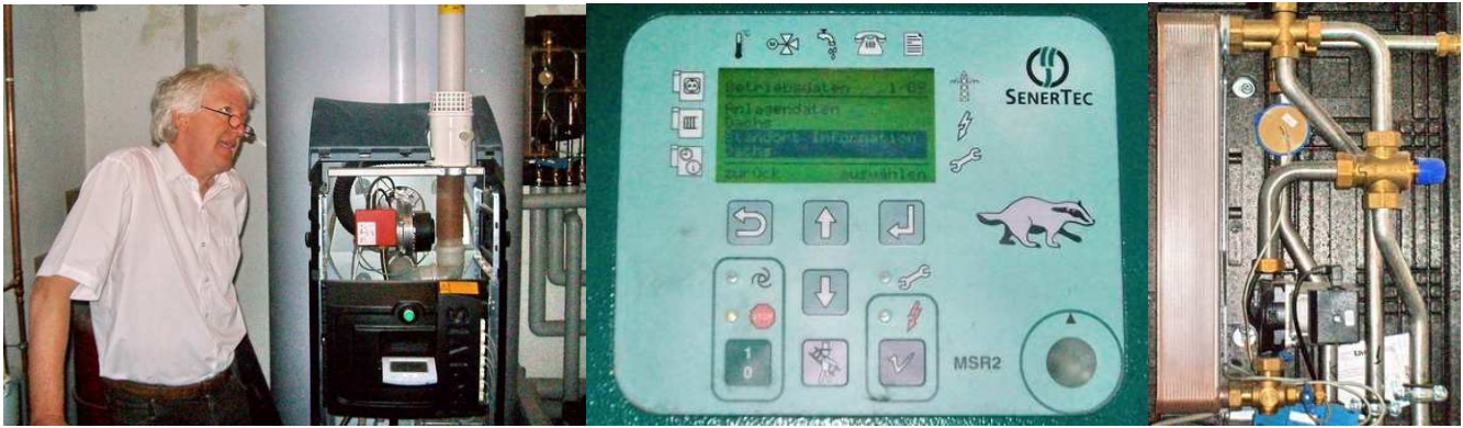
Joachim Kreuz vordem 950-Liter- Schichtenspeicher und geöffnetem Brennwertgerät, elektronische Infotafel am BHKW, ganz re: Platten-Wärmetauscher für Warmwasser
